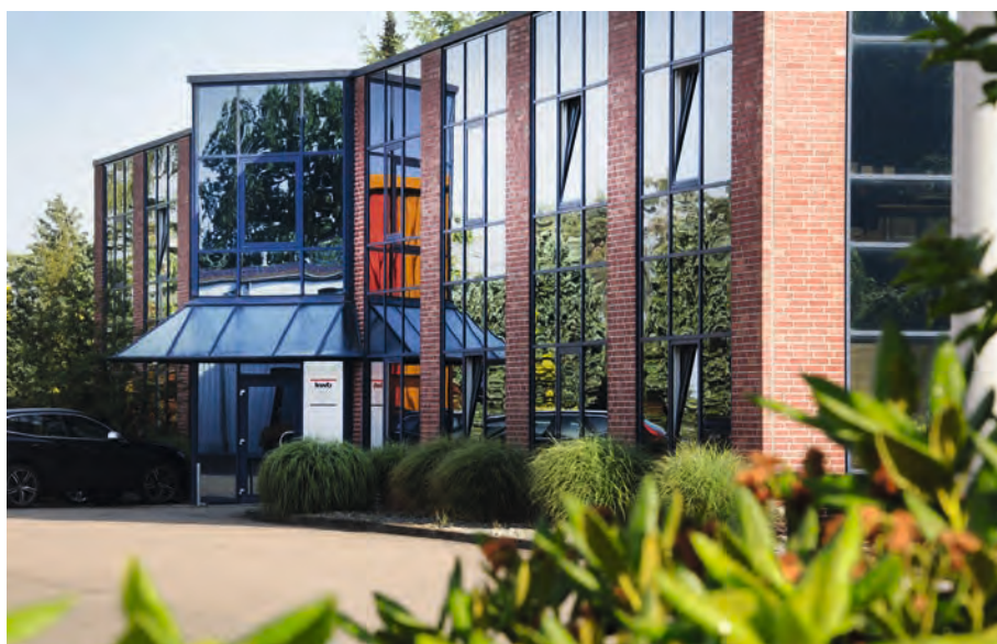
Sede central de kwb en Stuhr (Bremen, Alemania)
